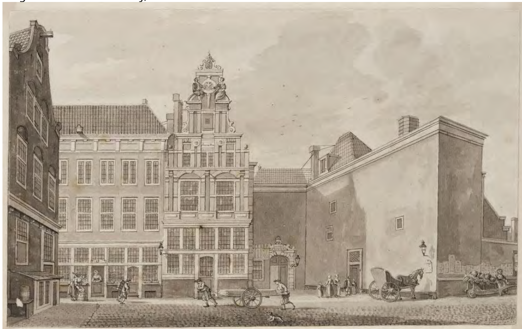
Sint Luciënsteeg, Burgerweeshuis met poort naar de meisjesbinnenplaats, rechts het in 1732 gebouwde deel 'M', H.P. Schouten, 1770 (Stadsarchief Amsterdam; Collectie Atlas Splitgerber)
