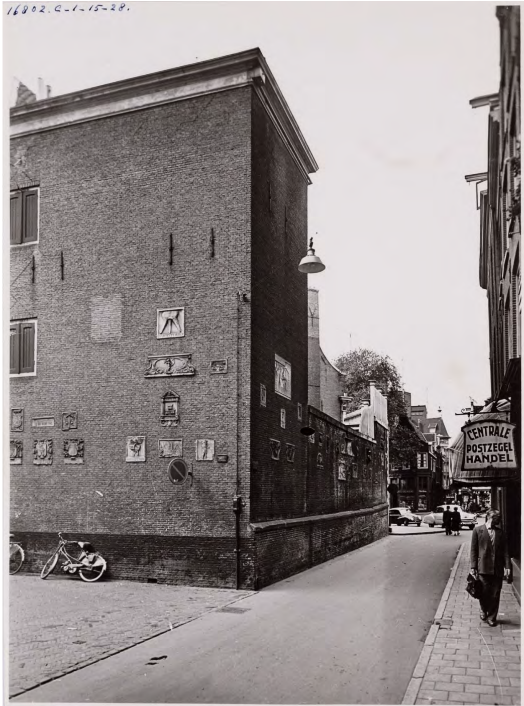
Sint Luciënsteeg, steeggevel bouwdeel M (gezien naar Nieuwezijds Voorburgwal) augustus 1955 (Stadsarchief Amsterdam, Archief van de Dienst Ruimtelijke Ordening en rechtsvoorganger: foto's)
